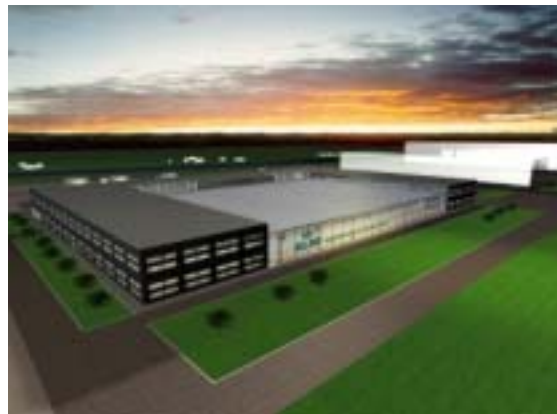
fig. 11 DE NIEUWE ENGINE SHOP
